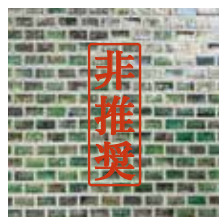
【積み材】 タイル張り
