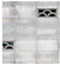
【壁材】 コンクリートブロック塀
