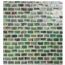
【壁材】 レンガ塀
