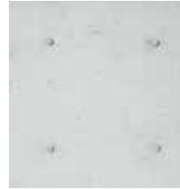
【セメント】 コンクリート打放し 網屋町エリアは 非推奨
